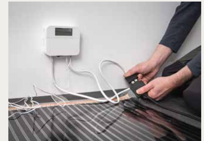
4 Installeer de thermostaat en sluit deze aan op de verwarmingsfolie.
