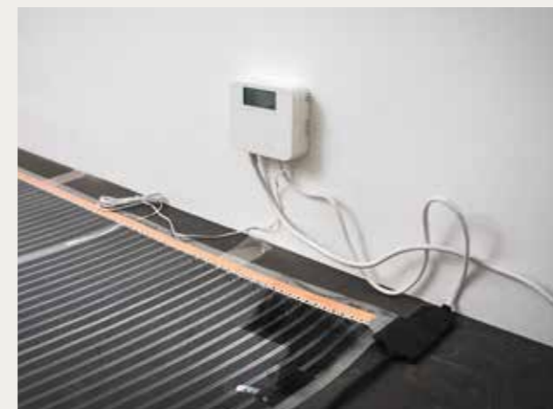
5 Steek de stekker van de thermostaat in het stopcontact.
